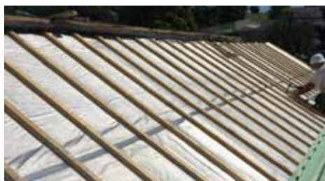
Finition de toiture : extérieur
