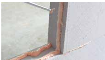
Collage de béton cellulaire
