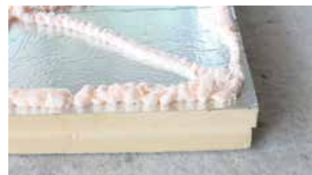
Collage de panneaux d'isolation
