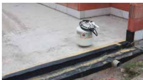
Pourtour des fondations
