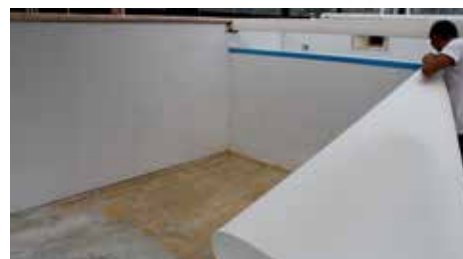
Pendant la construction de la piscine
