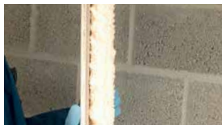
Collage de plaques de plâtre
