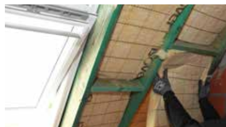
Finition de toiture : intérieur
